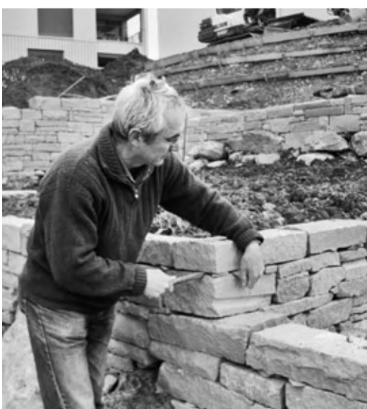
Marc Weizenegger bei Natursteinarbeiten.
